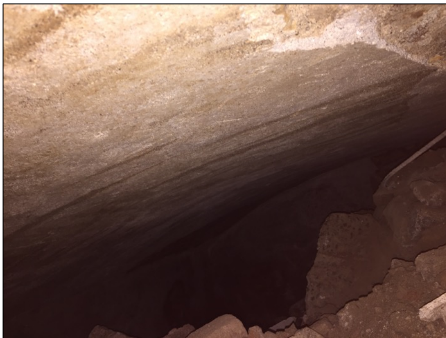
Fotografia 64. Detall arrebossat interior cisterna UE348.
