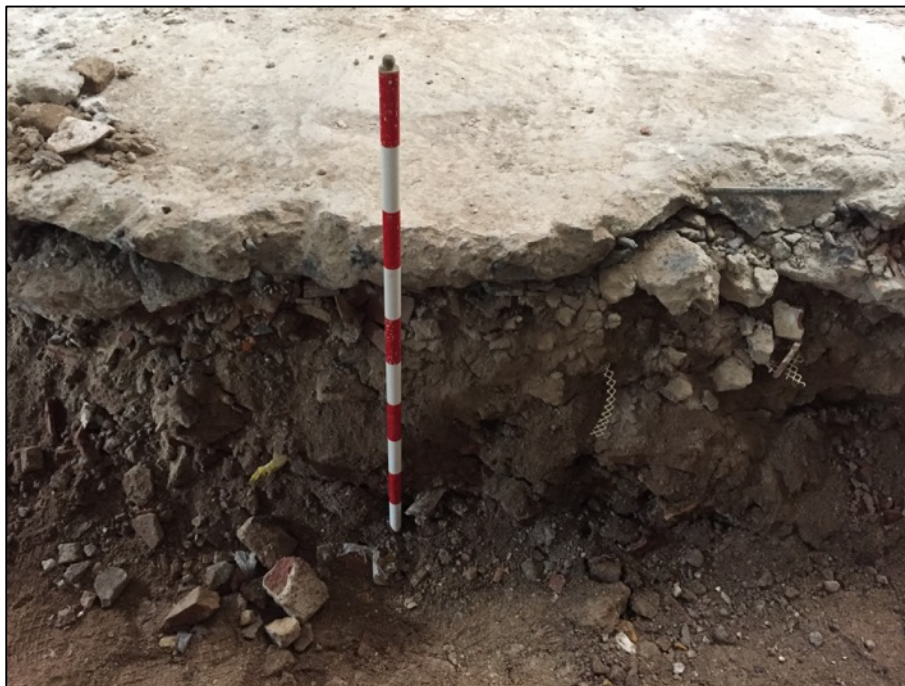
Fotografia 66. Tall estratigràfic amb llosa de formigó i runa contemporània localitzades a l'obrir rasa de sanejament.
