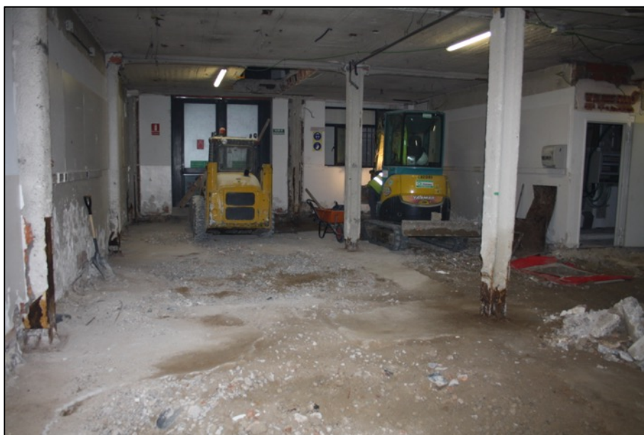
Fotografia 151. Encepats i nivell de runa UE202.
