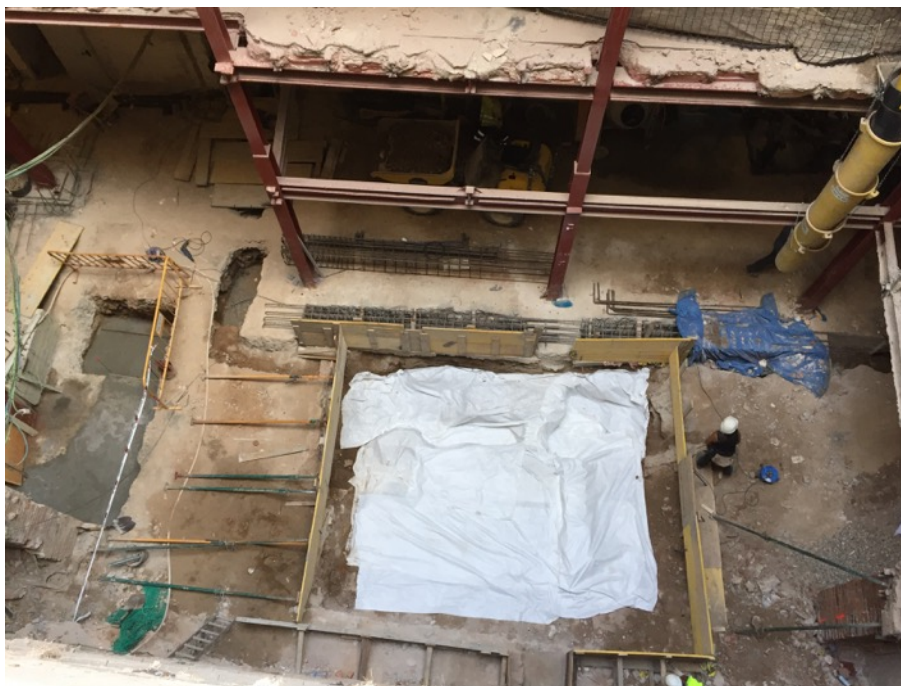
Fotografia 147. Cobriment de les estructures romanes del fossat de la grua amb geotèxtil.
