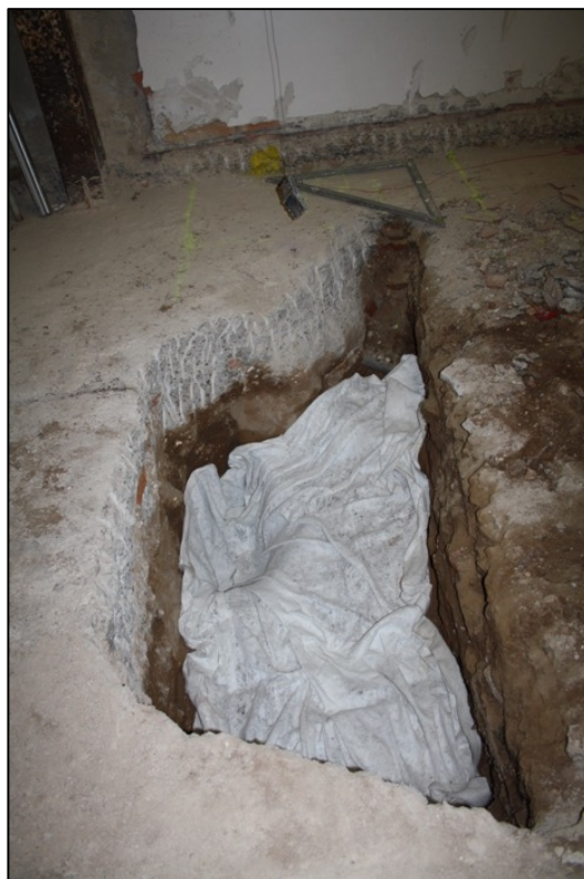
Fotografia 168. Cobriment amb geotèxtil de les estructures documentades.
