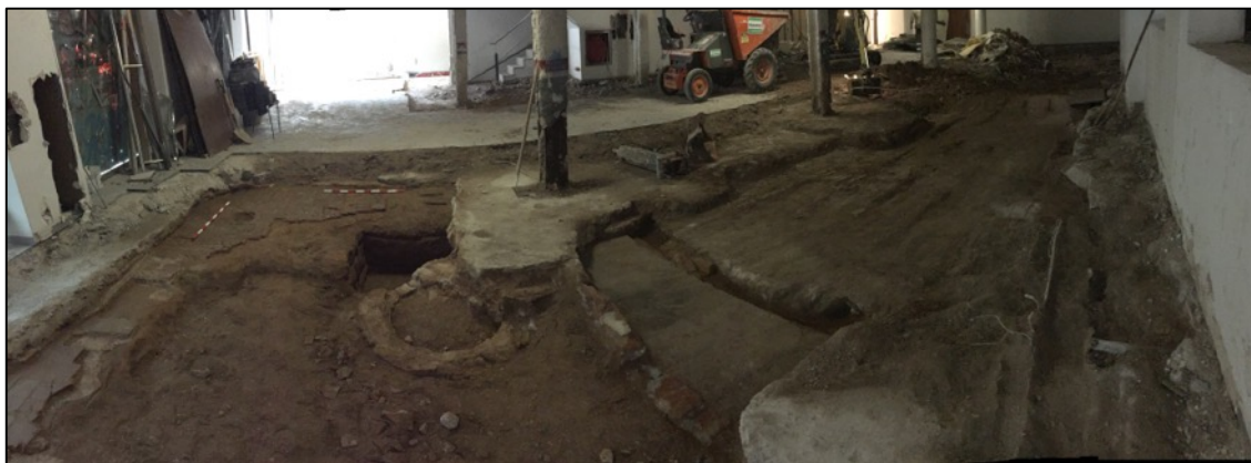
Fotografia 5. Vista general àmbit davanter amb restes arqueològiques i llosa de formigó UE167.
