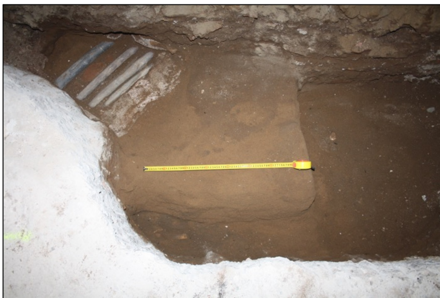
Fotografia 159. Sorres romanes UE210 amb canalització contemporània UE220.
