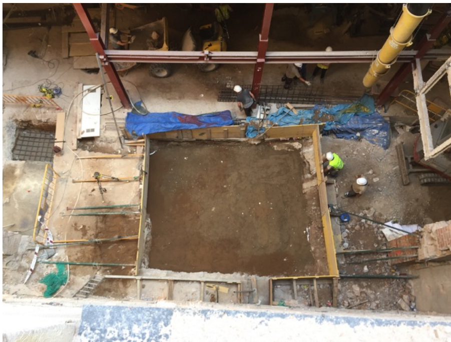
Fotografia 148. Protecció amb sauló de estructures romanes del fossat de la grua.
