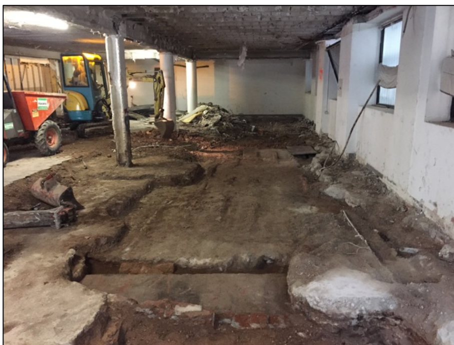
Fotografia 4. Vista de la llosa de formigó UE167.
