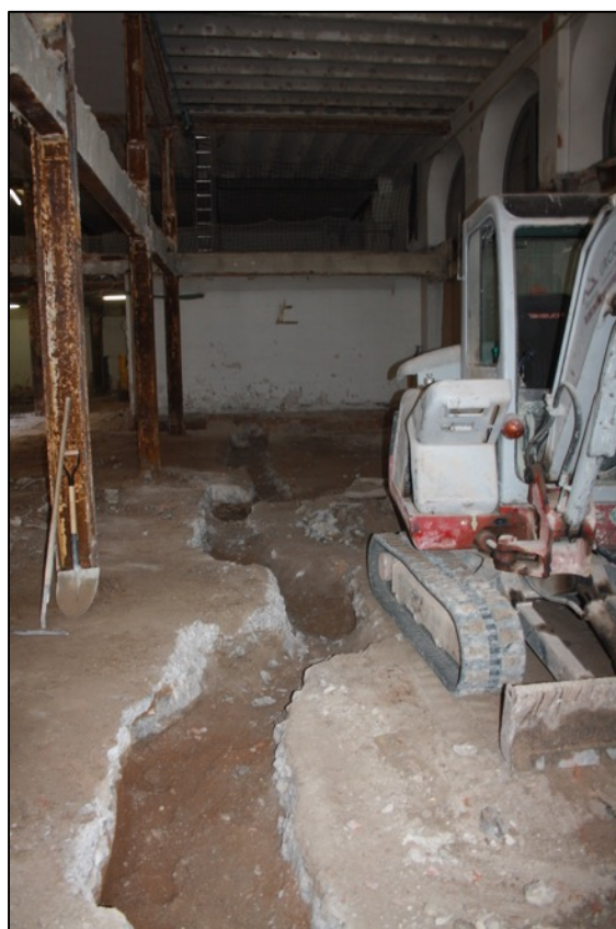
Fotografia 6. Obertura rasa perimetral pel reforç estructural.
