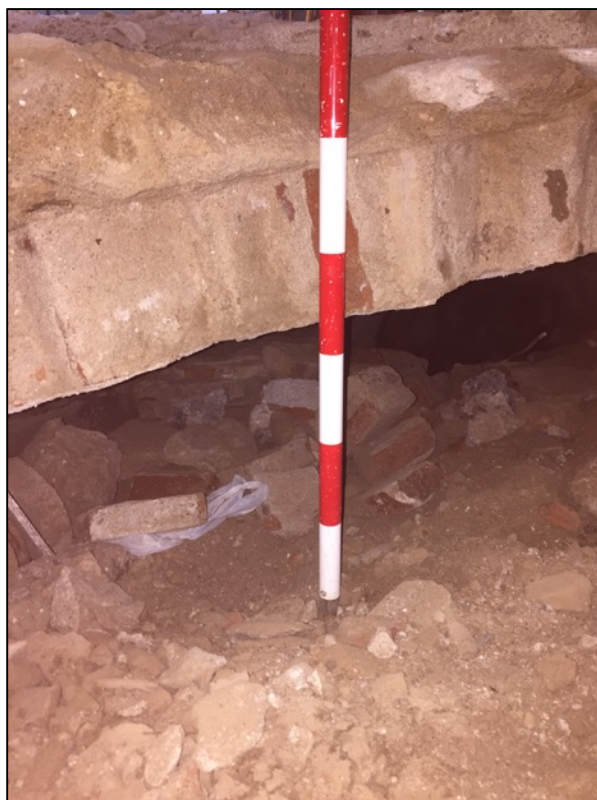
Fotografia 63. Detall volta coberta amb volta a sardinell cisterna UE348.
