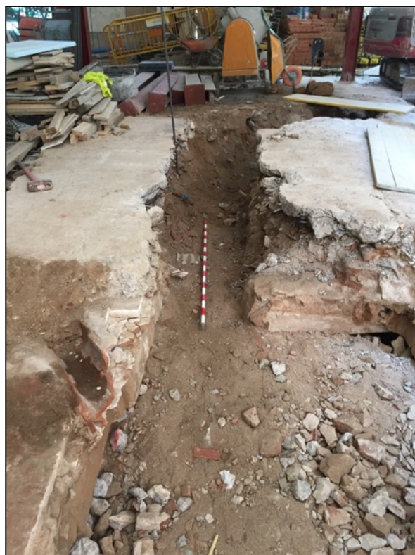
Fotografia 67. Rasa sanejament direcció carrer Ample.
