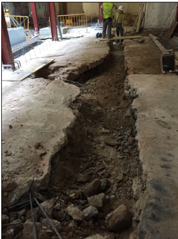
Fotografia 58. Tram rasa sanejament oberta en àmbit central del Sector Ample.
