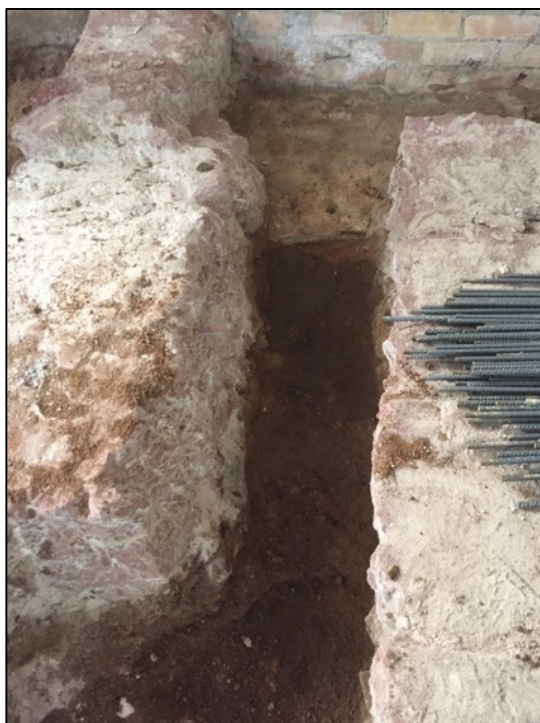
Fotografia 47. Cala reforç estructural sabata H-8 amb riosta UE159 i estrat s. IX UE154.
