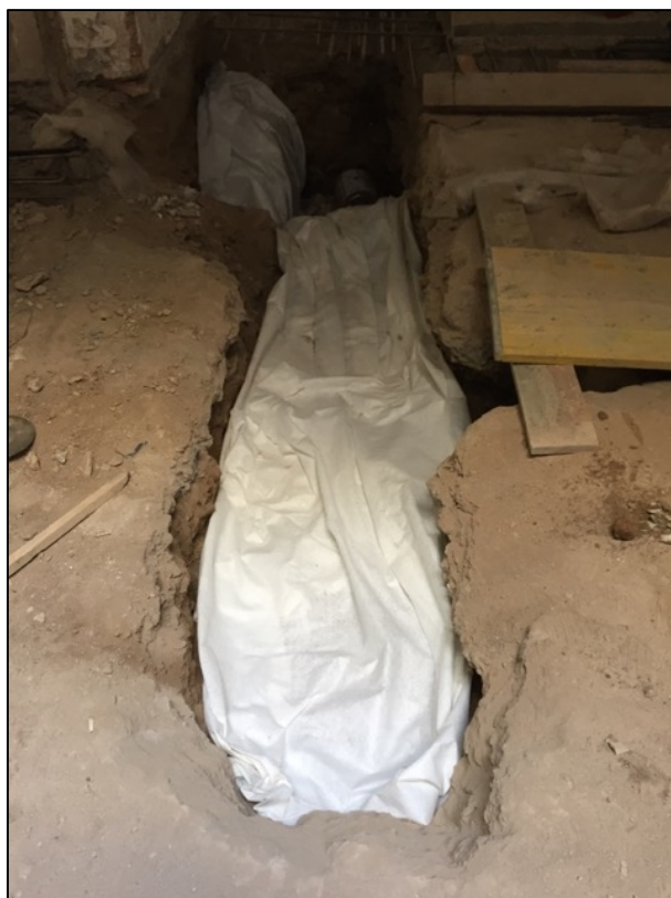
Fotografia 51. Cobriment amb geotètil estructures Sabates H-7 i H-8.
