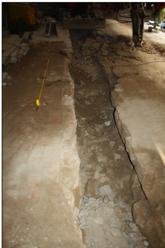
Fotografia 57. Obertura rasa sanejament resseguint rasa ja oberta UE353.
