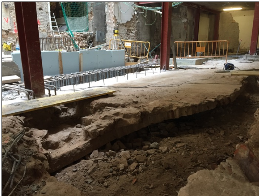
Fotografia 62. Vista al tall de la coberta de la claveguera UE348.
